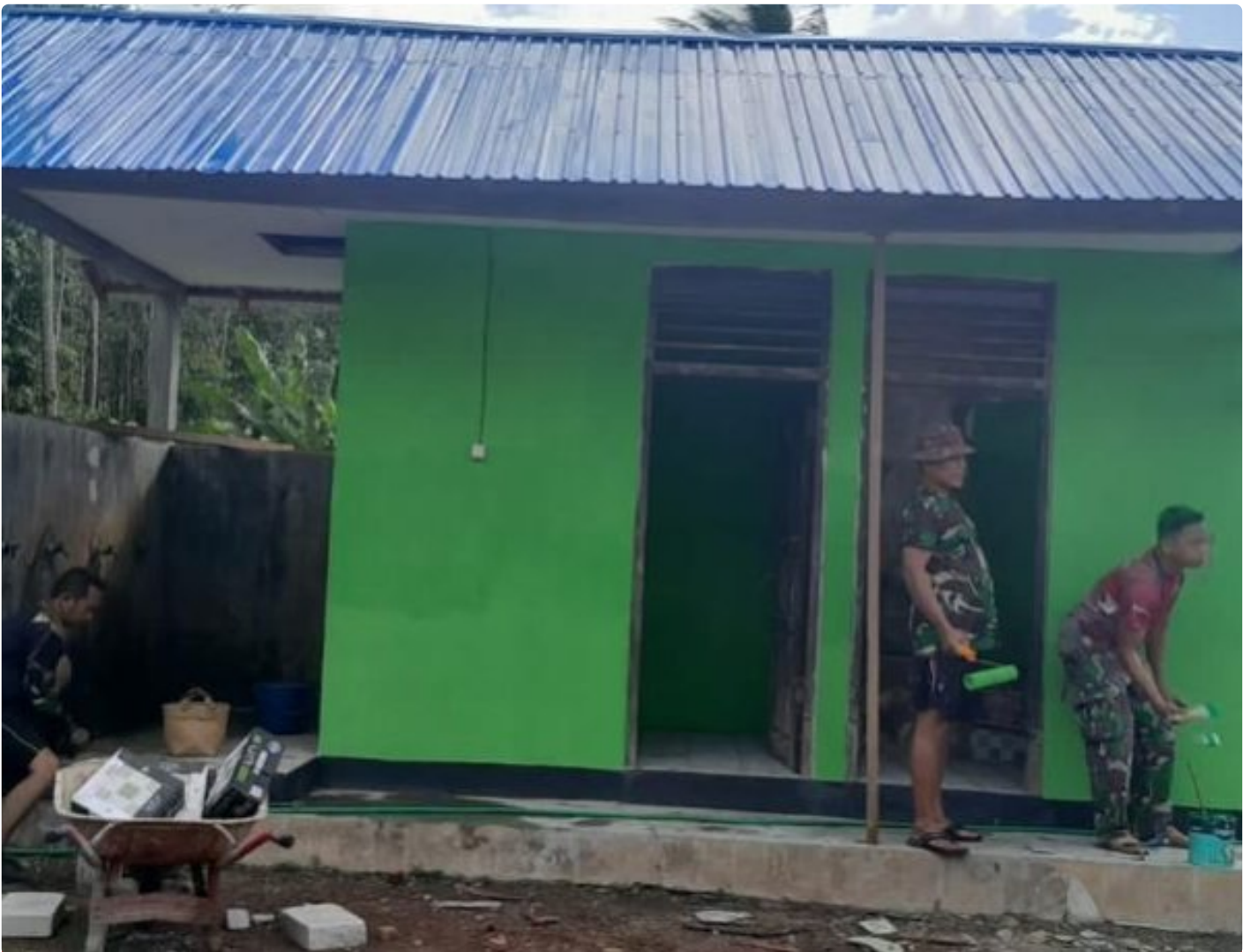
Pengerjaan Sasaran Rehab Masjid, Tinggal Finising
